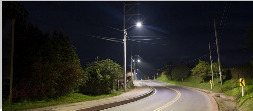
Realizamos la instalación de 820 luminarias led
