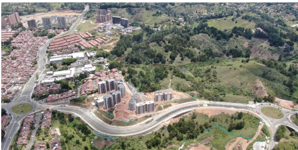
Tramo 11.1.2 Glorieta El Tanque – Comando de Policía
