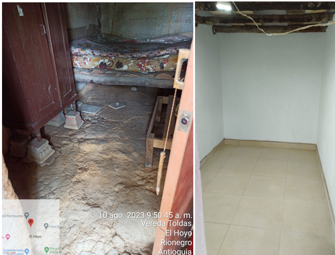
Vivienda ubicada en la vereda Toldas, El Hoyo – Antes y después
