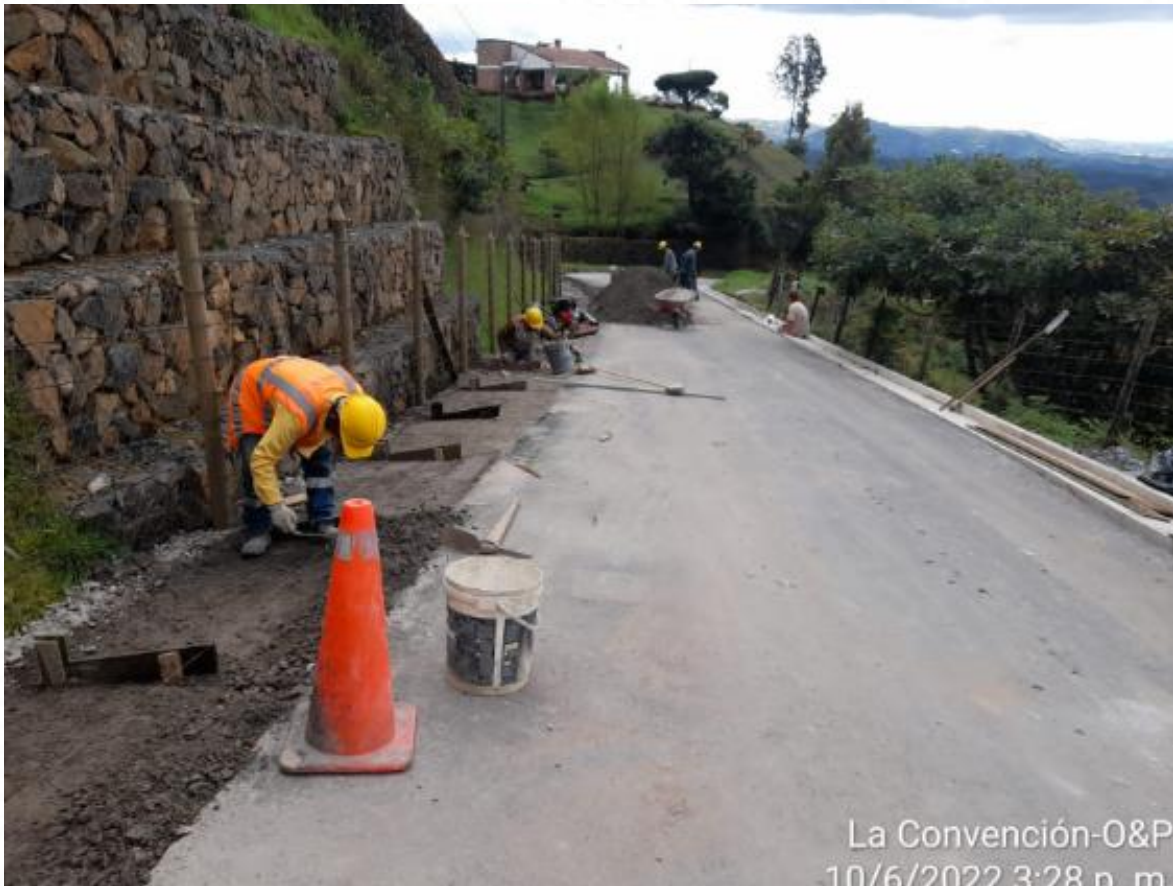
Avance de obra Vereda La Convención – Contrato IP032
