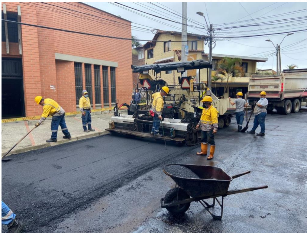
Primera capa de asfalto en el sector del Consejo
