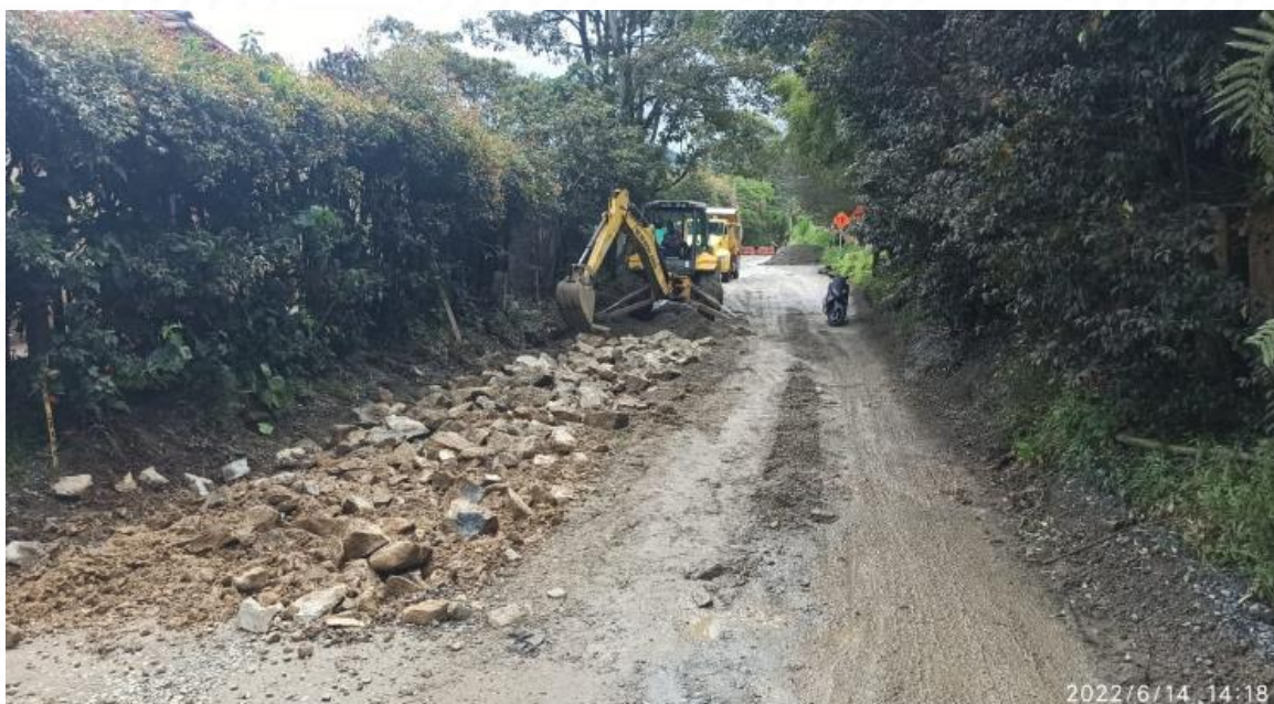
Fase inicial de la pavimentación - Contrato IP-026
