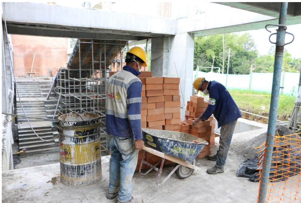
Foto: Obra Colegio San Antonio
