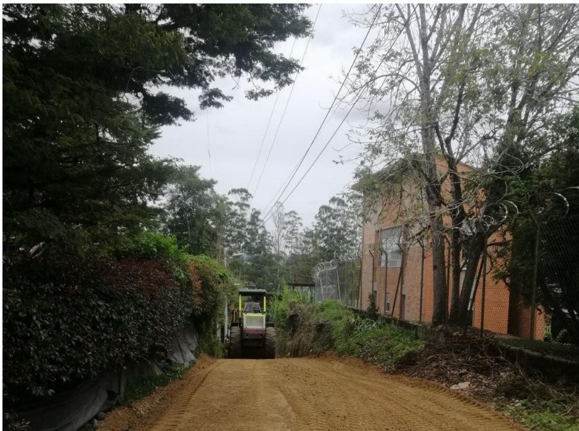
Intervención de la vía
