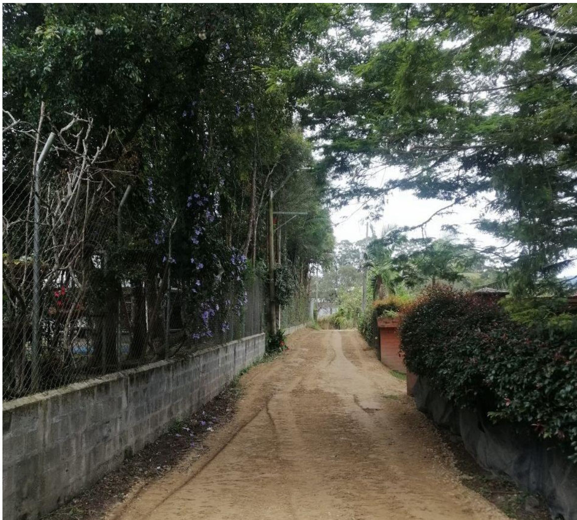
Base granular ya finalizada
